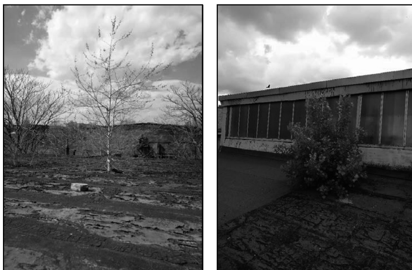
Рис. 7. Прорастание деревьев на кровле
