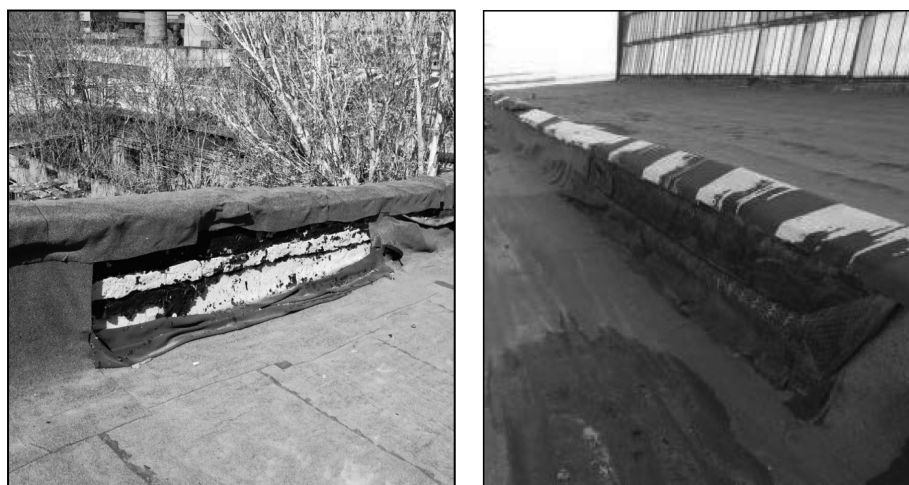
Рис. 4. Отклеивание рулонного ковра от вертикальных поверхностей
