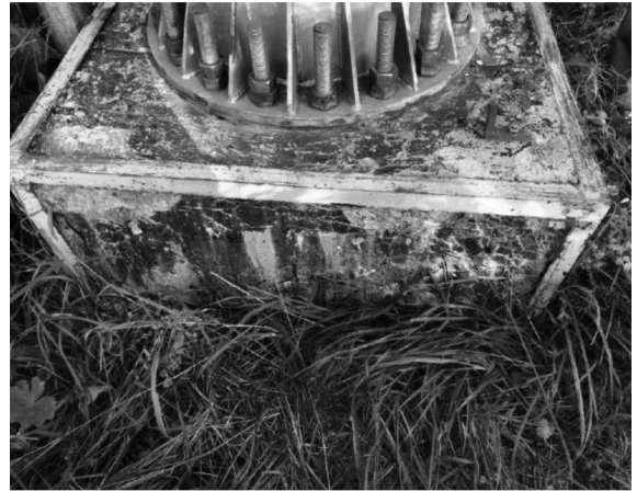
Рис. 3. Верхний уступ фундамента, выполненный с использованием анкерных микросвай
