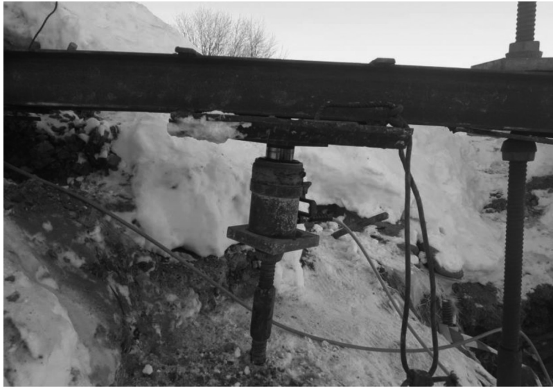
Рис. 8. Этап проведения натурных испытаний анкерных микросвай при строительстве линейного объекта
