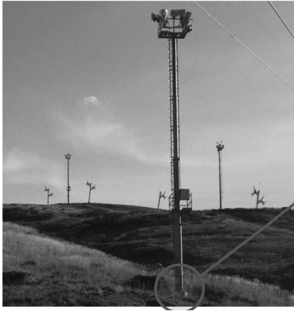
Рис. 2. Общий вид опоры освещения
