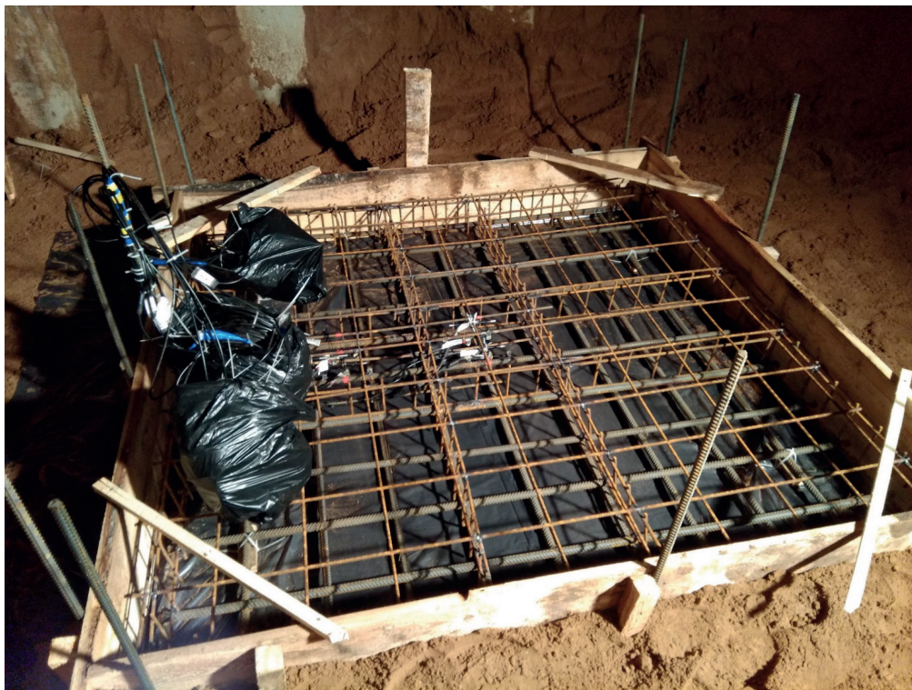
Рис. 3. Опытная плита перед бетонированием
