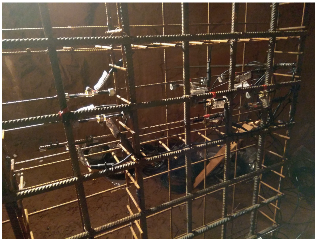
Рис. 4. Установка тензометрических датчиков в каркас плиты
