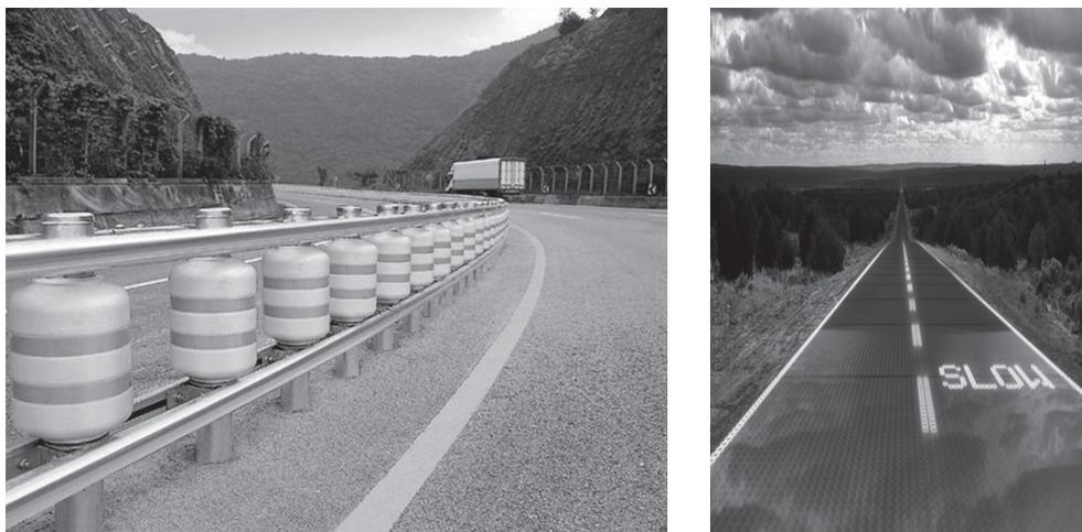
Рис. 2. Мягкий роликовый отбойник. Умная дорога
