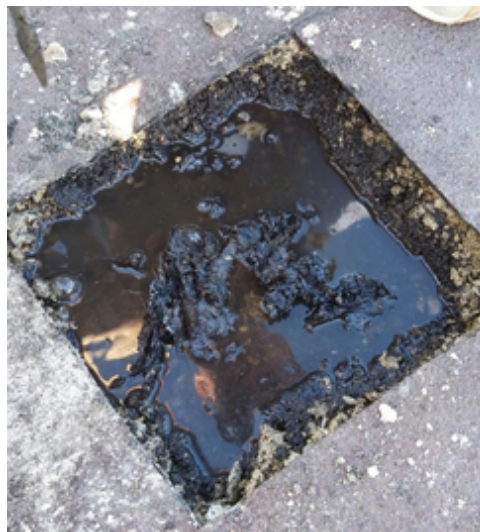
Рис. 4. Замачивание утеплителя
