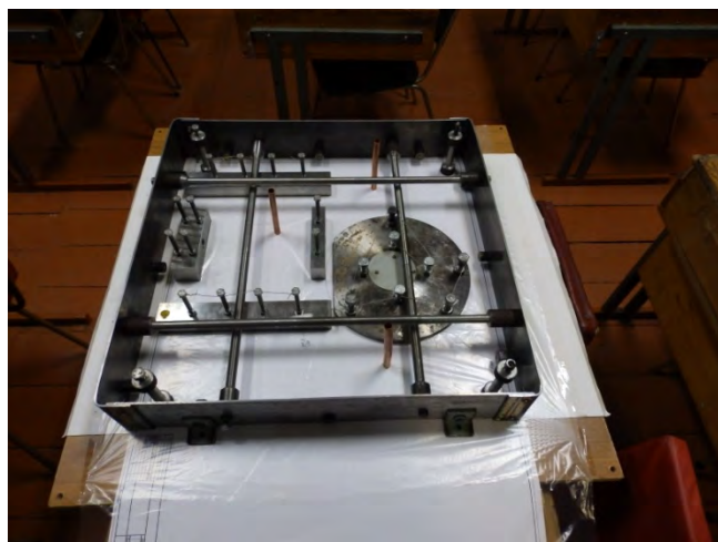
Рис. 1. Опалубка с арматурой и системой закладных элементов
