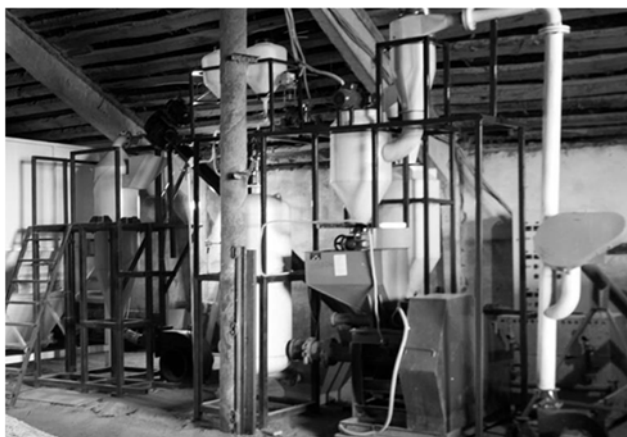
Рис. 2 – Внешний вид установки для переработки активированных сельскохозяйственных растительных отходов в биоэтанол
