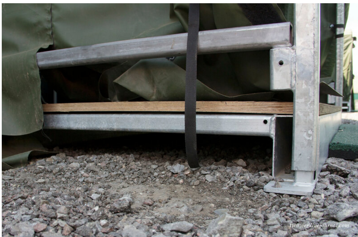
Рис. 5. Конструкция пола палатки автономного полевого лагеря АПЛ-500. [Электронный ресурс]. – URL: https://www.arms-expo.ru/articles/armed-forces/ustroystvo-avtonomno-polevogo-lagerya-apl-500/ (дата обращения 23.07.2023)
