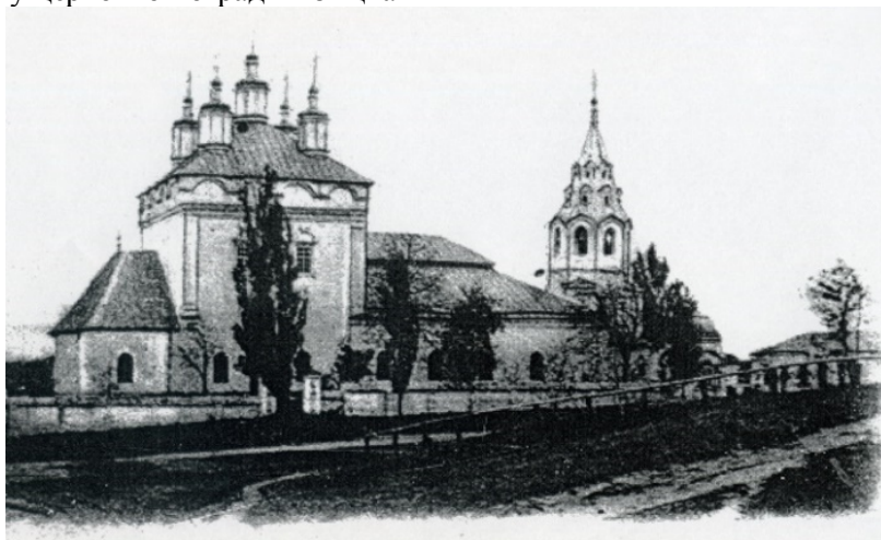
Рис. 5. Северный фасад Успенско–Николаевского собора. Фото 1911 г.
