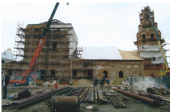
Рис. 9. Храм в процессе реставрации фасадов и колокольни. Фото 2005 г.
