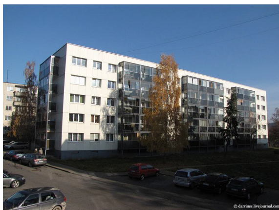
Рис. 3 Реновация панельного жилого дома в районе Жирмунай города Вильнюс, Литва: а – внешний вид до реновации; б – внешний вид после реновации
