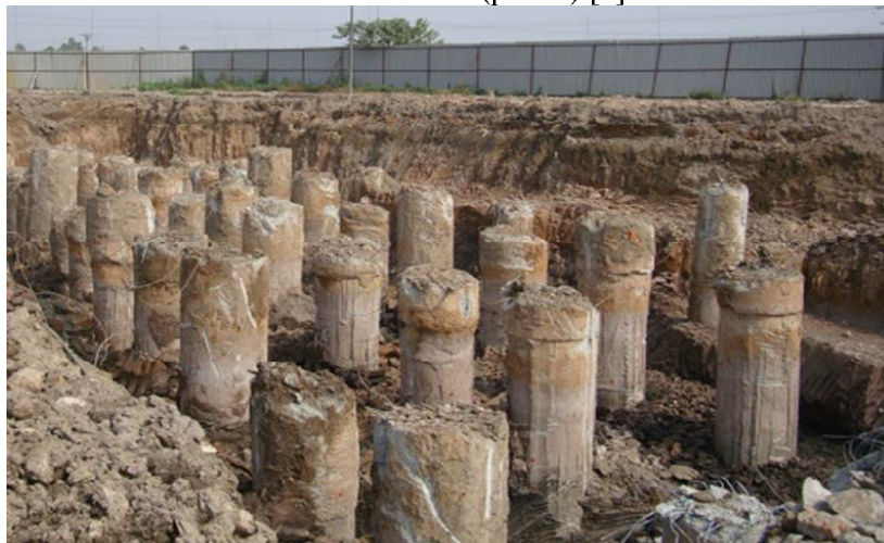
Рис. 1. Буронабивные сваи при сооружении фундамента башни «DOLPHIN PLAZA» (Вьетнам)
