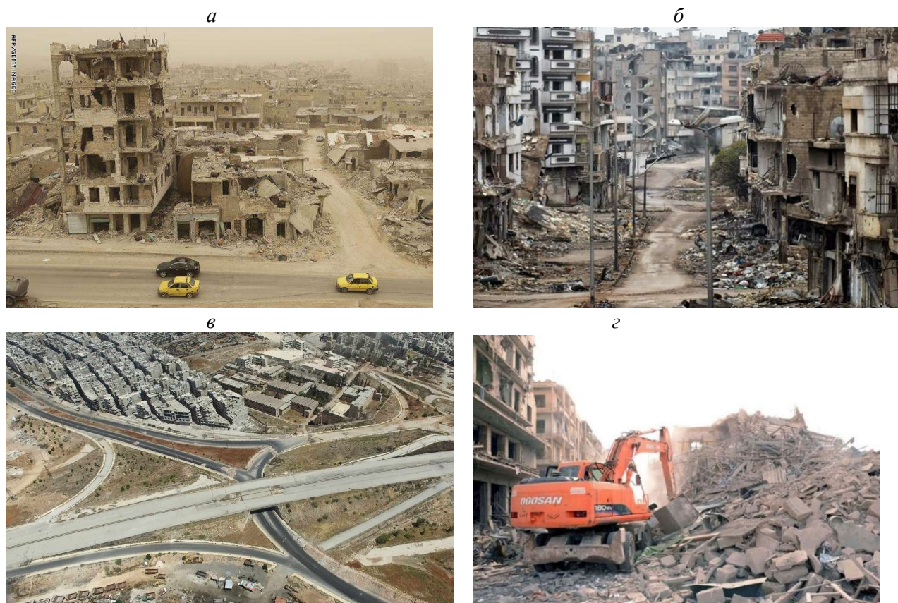
Рис. 2. Состояние дорог в Сирии после военных действий:
