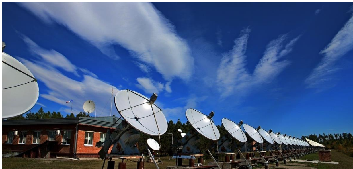
Рис. 2. Часть антенной решетки СРГ-48. Диаметр антенн 1.8 м, расстояние между антеннами 4.9 м. Белые антенны большего диаметра на конце луча остались от антенной решетки ССРТ. Сигналы с антенн с помощью волоконных линий, расположенных в тоннеле, передаются в рабочее здание за антеннами
