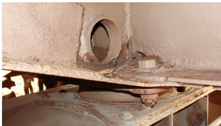
Рис. 2. Сквозная коррозия хребтовой балки пассажирского вагона
